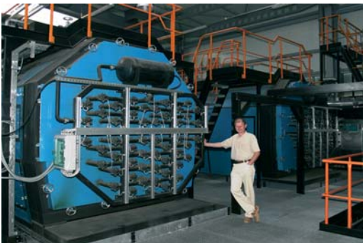
Паровой котёл с очисткой 32 бара сверхдавления
