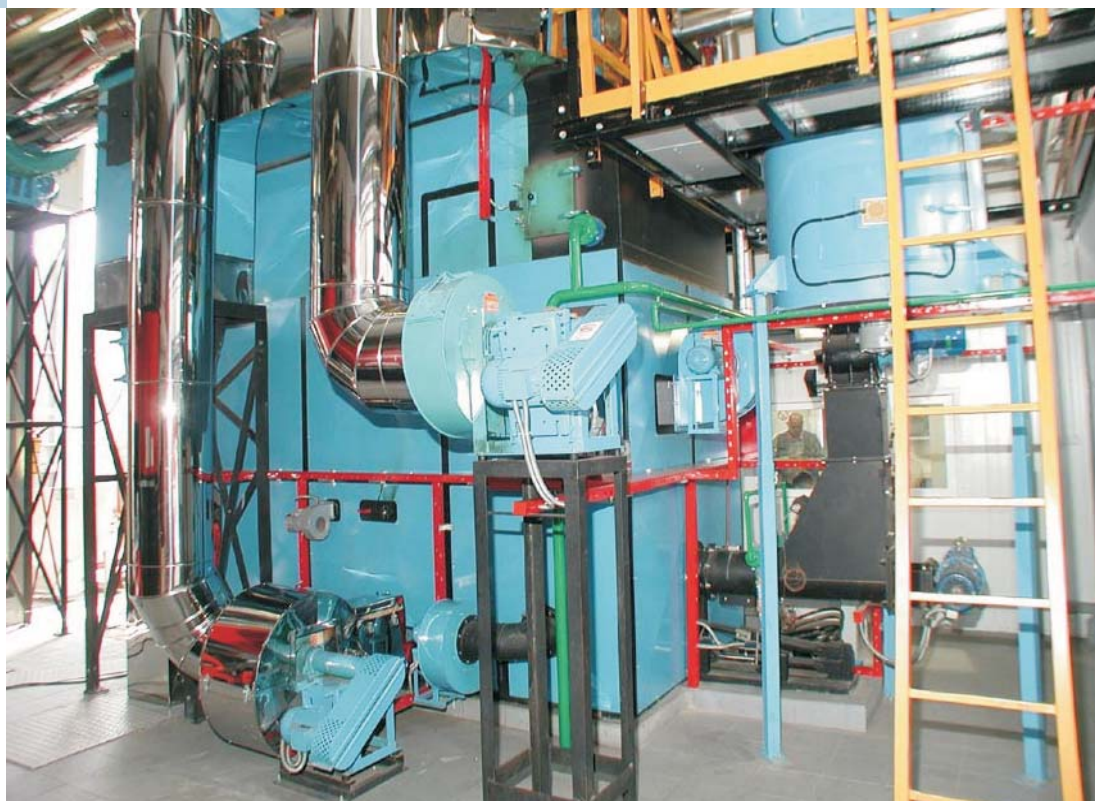
Топка для сжигания древесных отходов мощностью 1 MW
