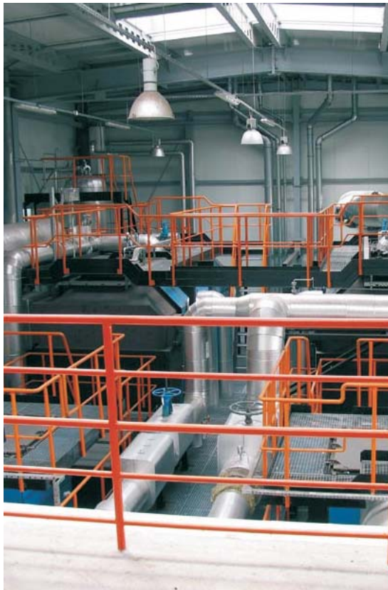
Электрический блок (вид сверху)
