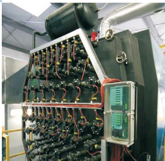
Оборудование для очистки котла
