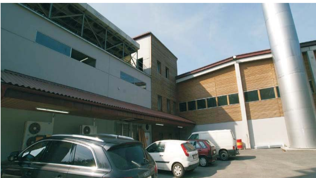
Объект Aschbach – вид снаружи
