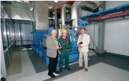
Турбогенератор мощностью 2,65 \text{ MW}
